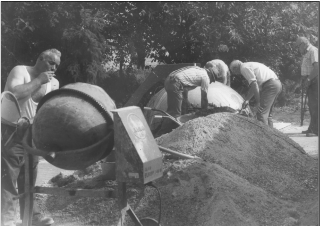
Bau der Kuppel 1984
